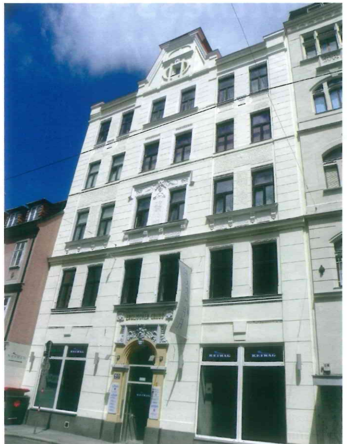
Die Reiwag-Zentrale in der Burggasse 60 in Wien.
