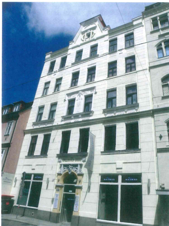
Die Reiwag-Zentrale in der Burggasse 60 in Wien.
